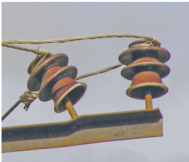
Рис. 5. Низкая механическая прочность штыревого узла изоляции
